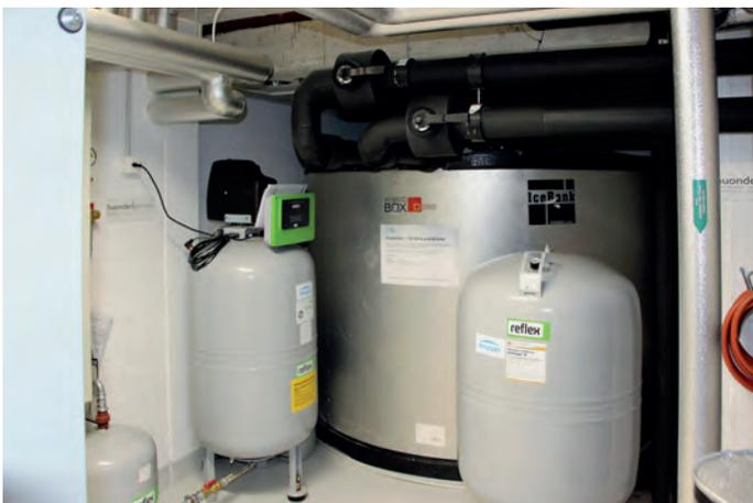
■ Zentrale Elemente des innovativen Energiesystems sind eine kompakte Energiezentrale mit einer Hybridbox und ein Eisspeicher (Mitte), welche im Sommer als Energiequelle für die Warmwassererzeugung eingesetzt sind.
