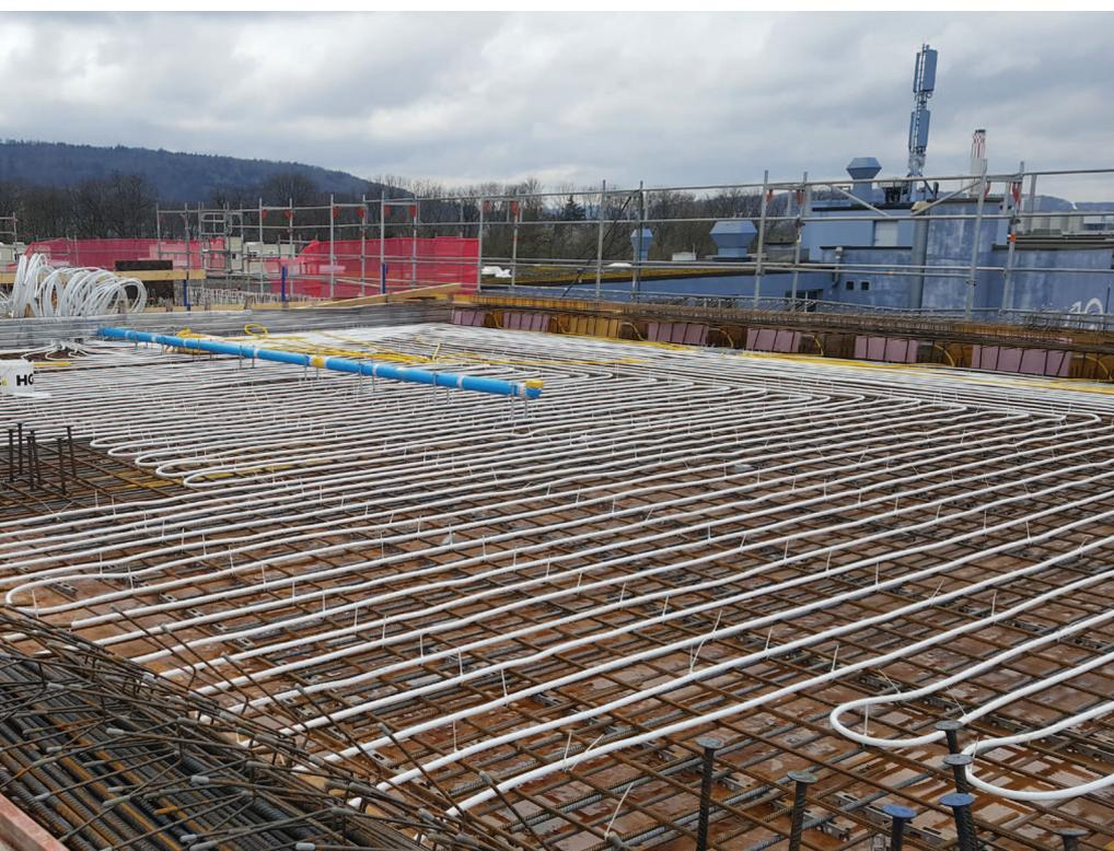
Ein mit Wasser betriebenes thermoaktives Bauteilsystem heizt und kühlt den SMGV-Neubau über die Betondecken.
