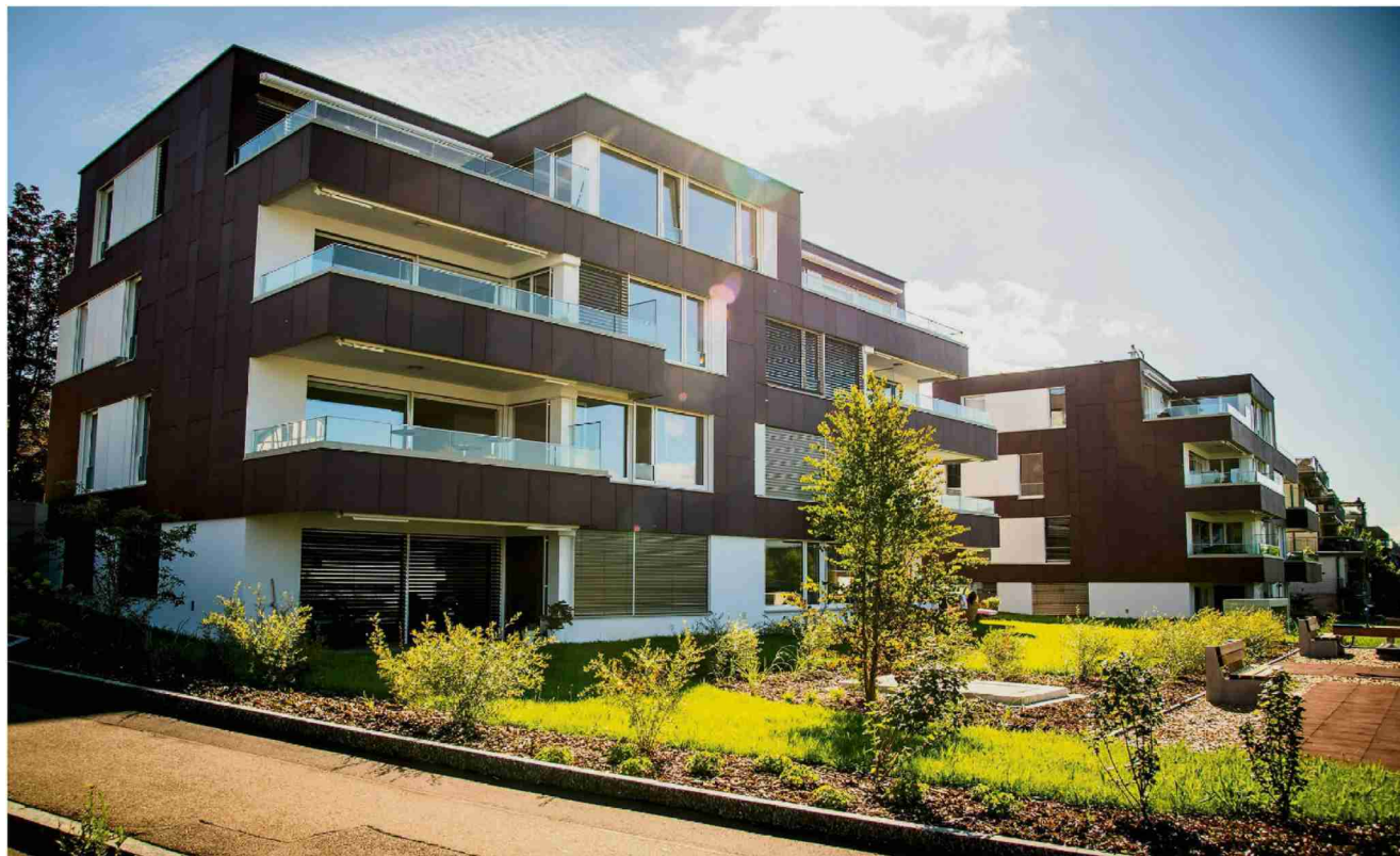
Cleveres Energiemanagement: Die Fassaden und Dächer der Häuser in Männedorf ZH bestehen aus weissen und braunen Fotovoltaikmodulen. Foto: Stiftung Umweltarena
